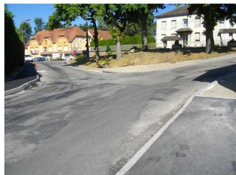
La chaussée est calibrée à 6 m dans la partie jusqu'à l'usine Clerc Industrie pour permettre l'accès aux poids lourds, y compris ceux de Trans Inter qui se rendent à leur dépôt. Au-delà elle n'est plus que de 5 m. Les bordures présentent un effet de paroi destiné à faire baisser les vitesses. Pour la sécurité, plusieurs passages piétons sont prévus.
